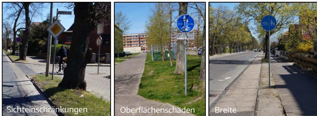
**Abb. 22:** Radführung im Seitenraum, Konfliktpotenziale (Sicht, Oberflächen, Breite)
