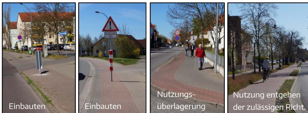
**Abb. 23:** Radführung im Seitenraum, Konfliktpotenziale (Einbauten, Nutzungsüberlagerungen, Nutzung entgegen der zulässigen Fahrtrichtung)
