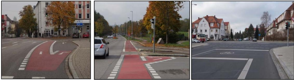
**Abb. 57:** Beispiele zur sicheren und attraktiven Radverkehrsführung an Knotenpunkten
