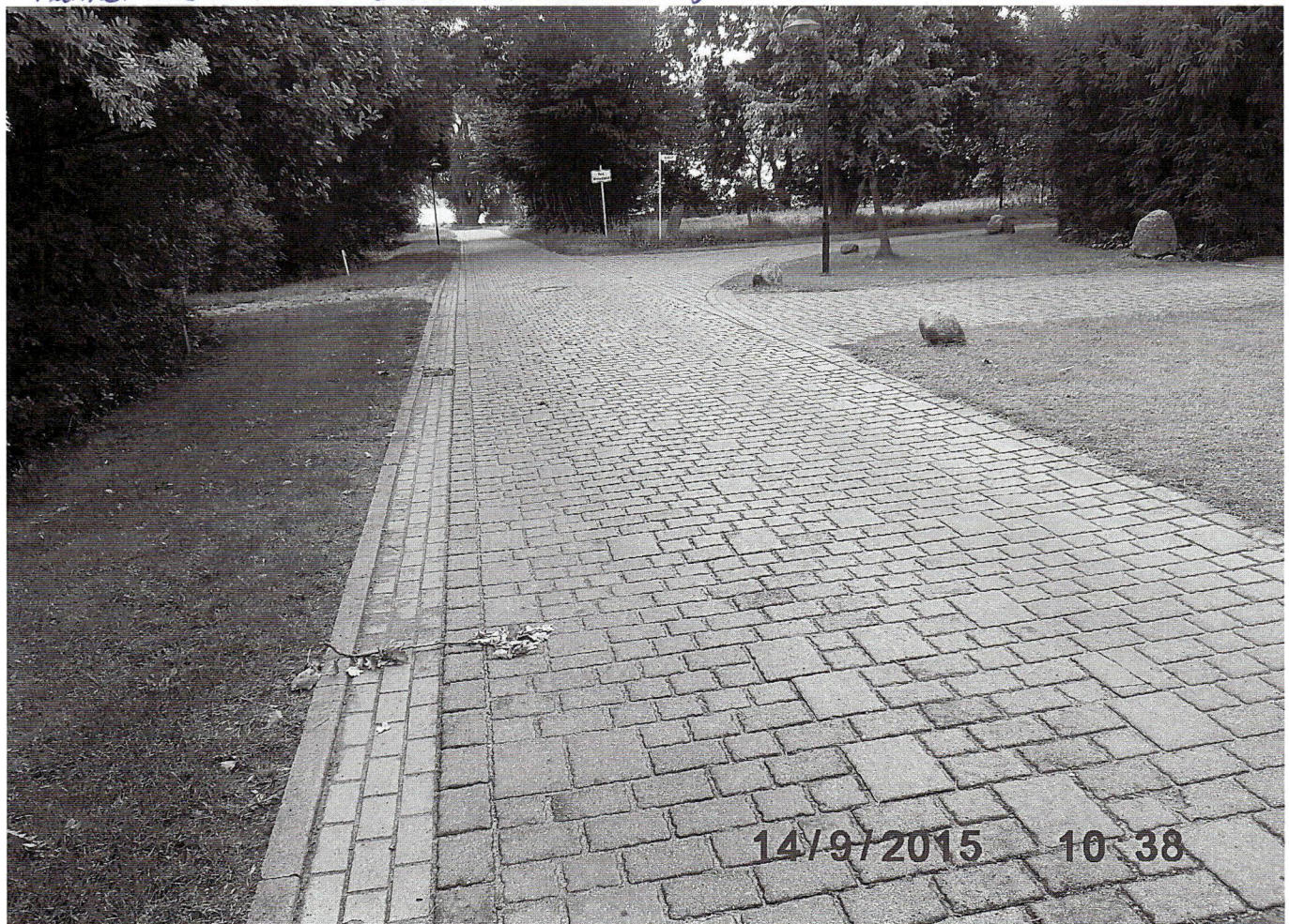
Punkt 3 - 4 ( Blick in Richtung Punkt 3 )
