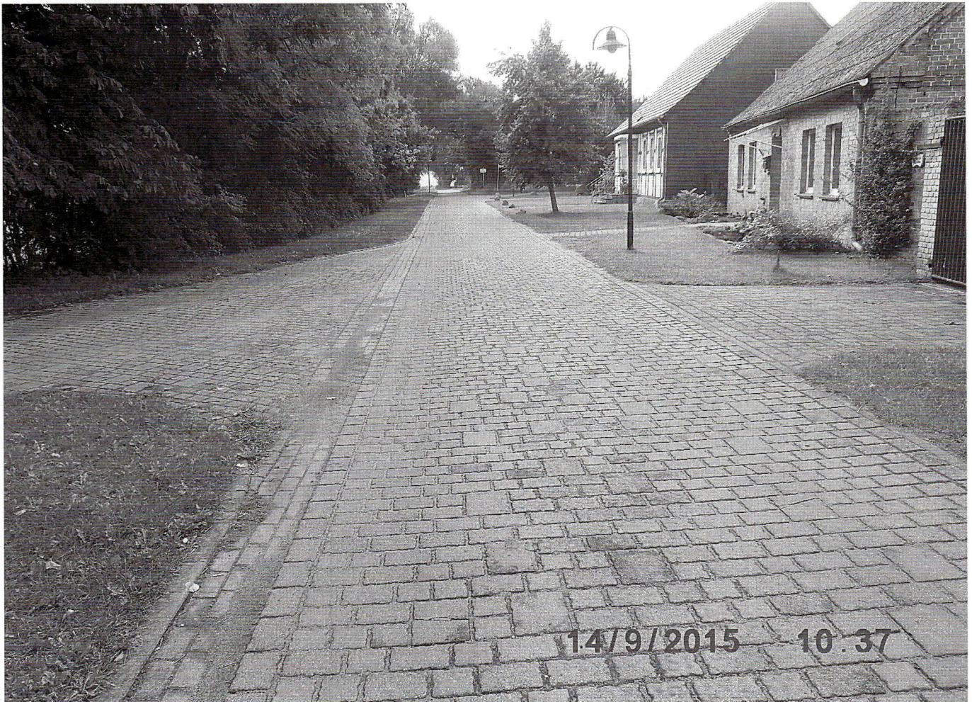
Punkt 3 - 4 ( Blick in Richtung Punkt 3 )
