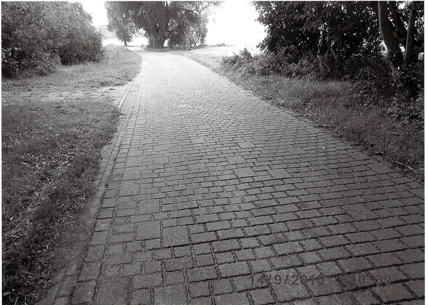
Punkt 3-4 (Blick auf Punkt 3)
