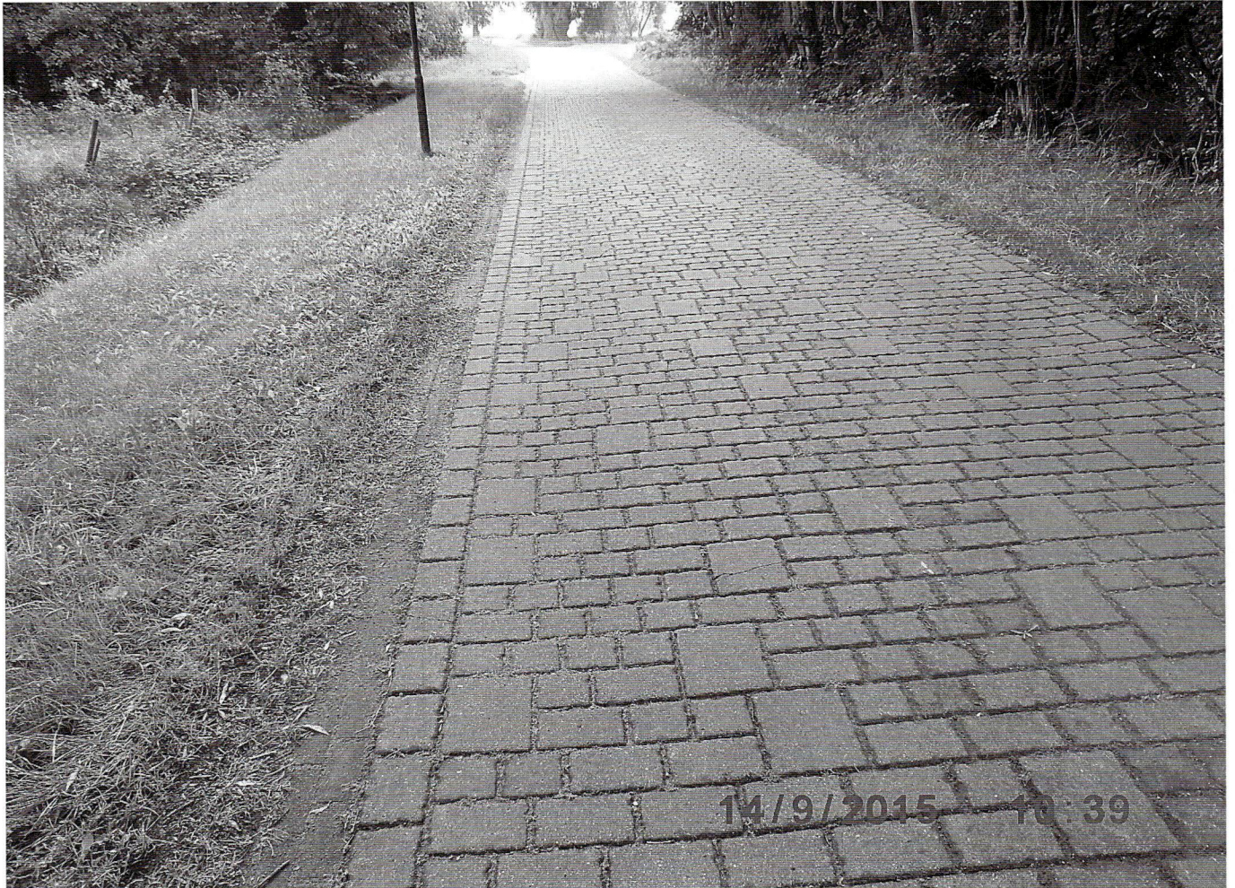
Punkt 3-4 (Blick in Richtung Punkt 3)
