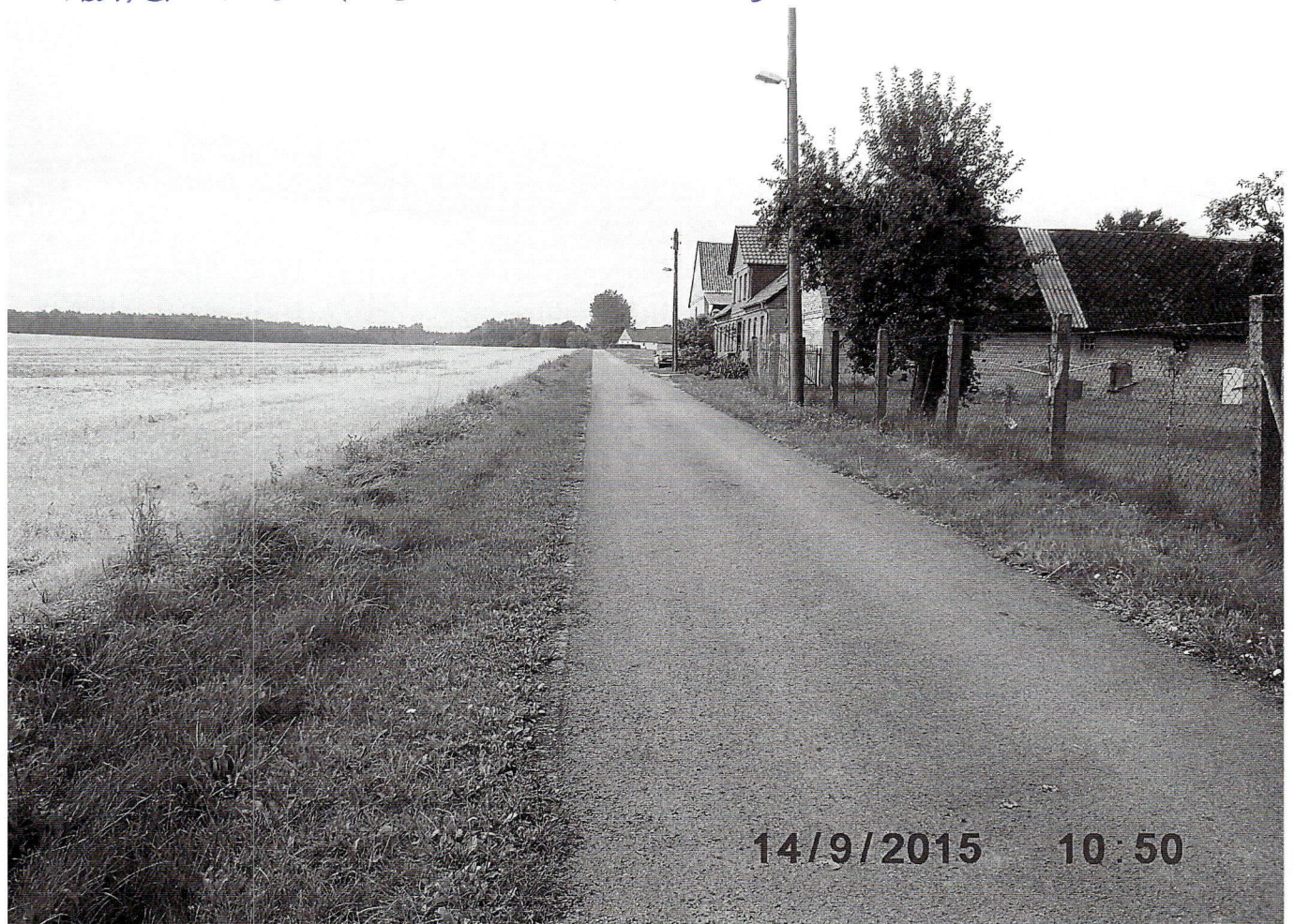
Punkt 1-2 (Blick in Richtung Punkt 2)
