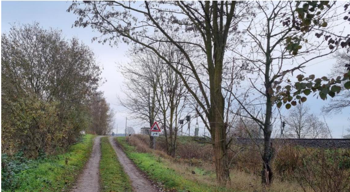
Abbildung 6: Bahnübergang mit Schranke und Ampel (Quelle: Auftraggeber)
